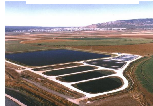
Serbatoi di accumulo
