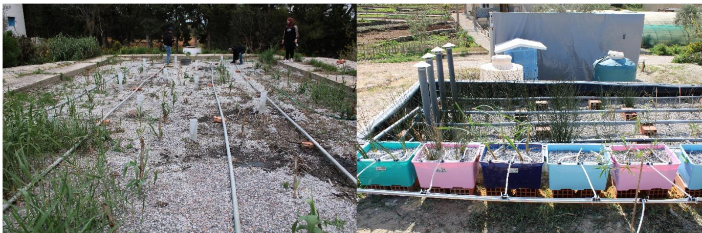
Foto 1. L'impianto di fitodepurazione di Jouggar, Zaghouan.
